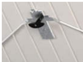
Serratura con il cilindro di chiusura bilaterale
