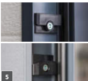
Sistema impedisce la caduta dell'anta.
